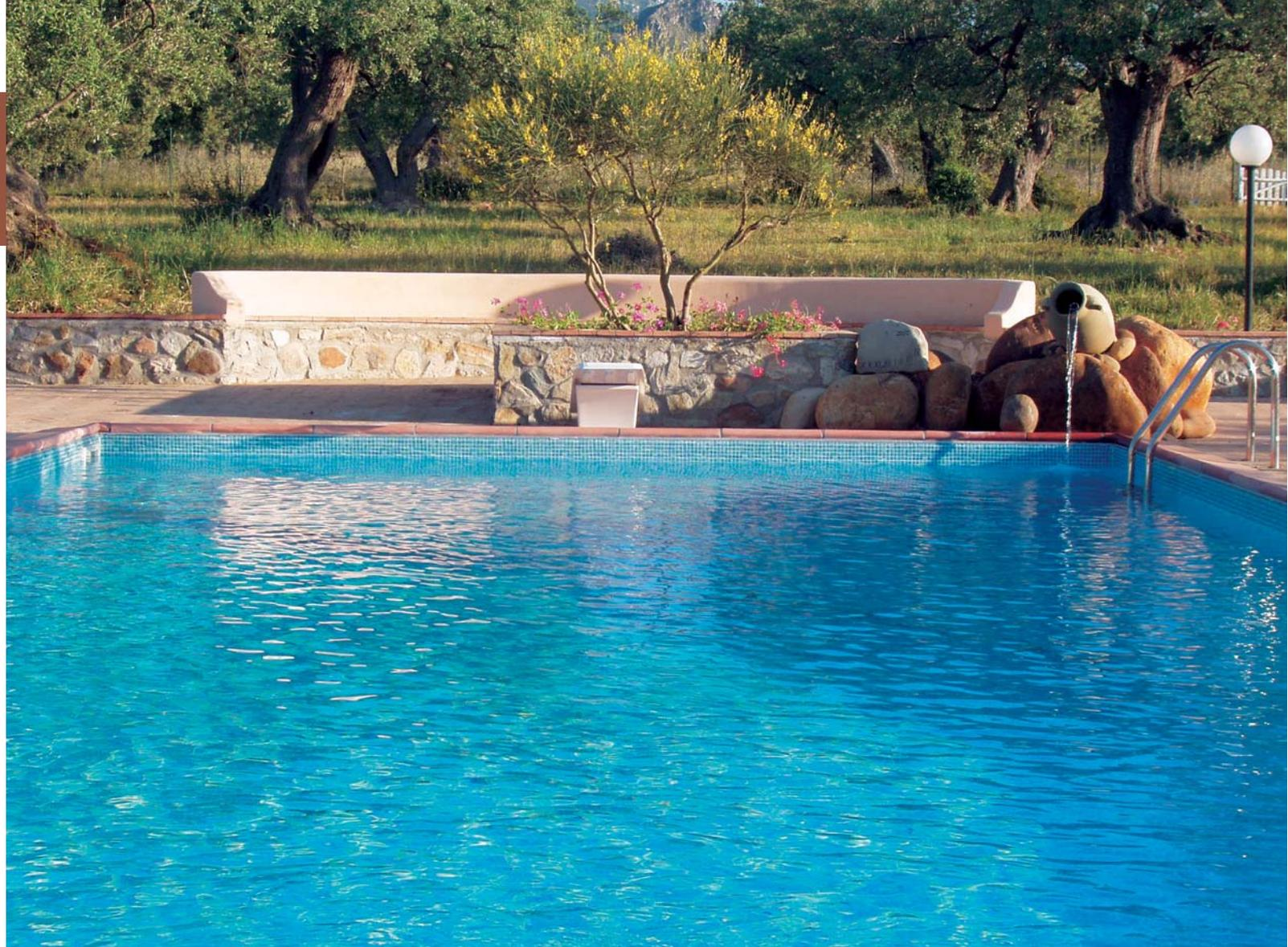
In questa pagina, di dimensioni 12x6 metri, con una profondità variabile da 1,20 a 2 metri, la piscina è dotata di impianto idromassaggio sulla scala di accesso. Realizzata a tecnologia mista, ha il rivestimento interno in PVC del tipo a mosaico.
